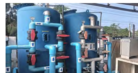
廃水処理システム用の オイルスキマーとカーボンフィルタータンク (TCFG)
