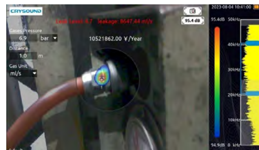
カメラによるエア漏れ検査
