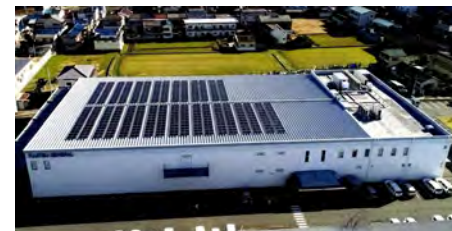
松原事業所屋上の太陽光パネル (2024年1月稼働)
